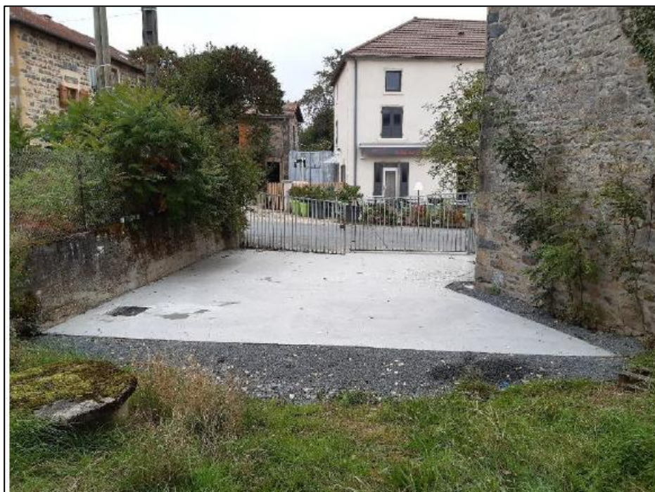
Figure 10 : Maintien du dallage sur la zone de pollution résiduelle
